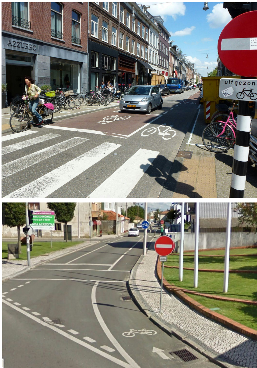
Fig. 10: Contraflow para velocípedes em Amesterdão e Gafanha da Nazaré. A primeira imagem mostra também uma bike-box no sentido único para tráfego motorizado.
